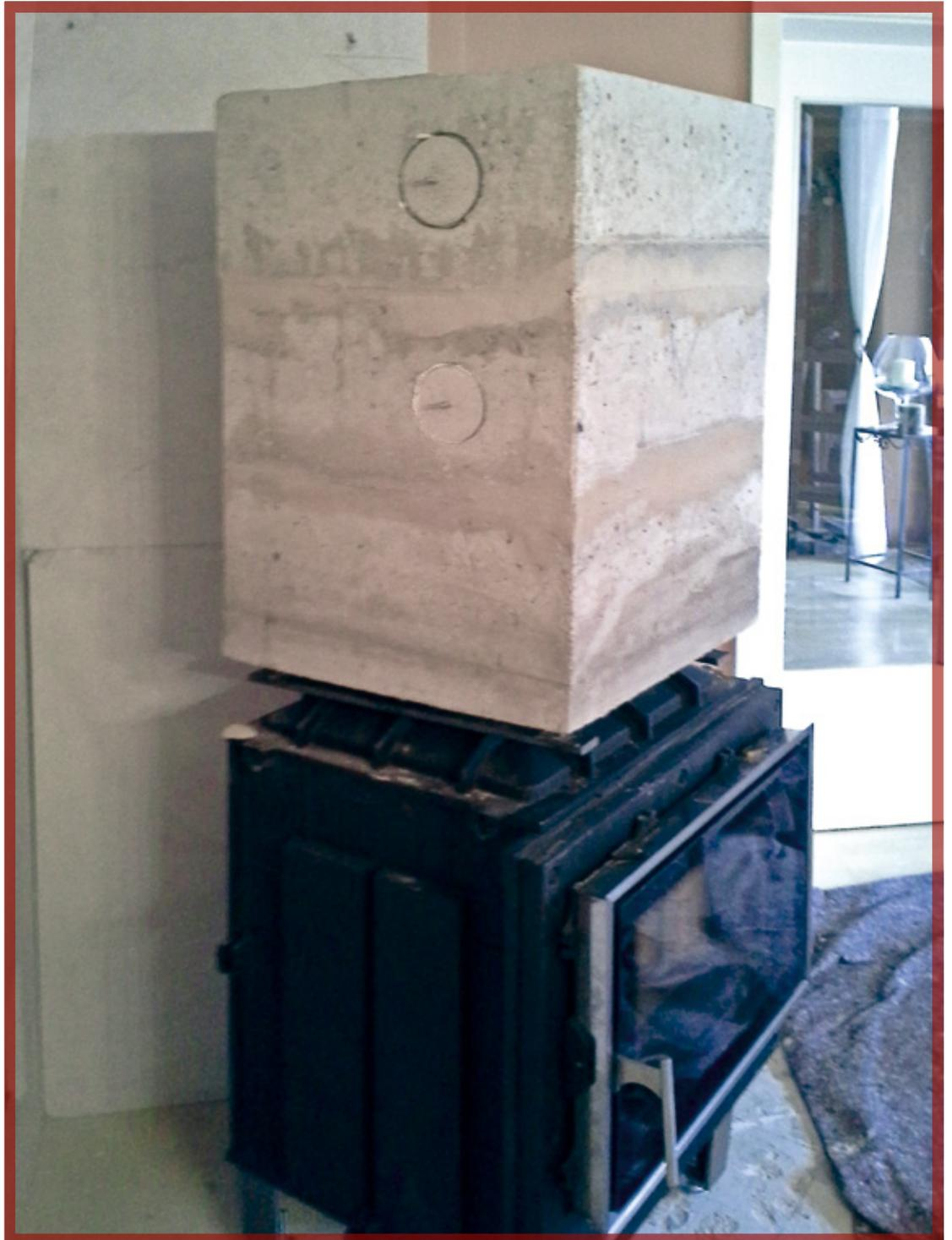
3. Zugaufsatzteil mit Putzdeckel
