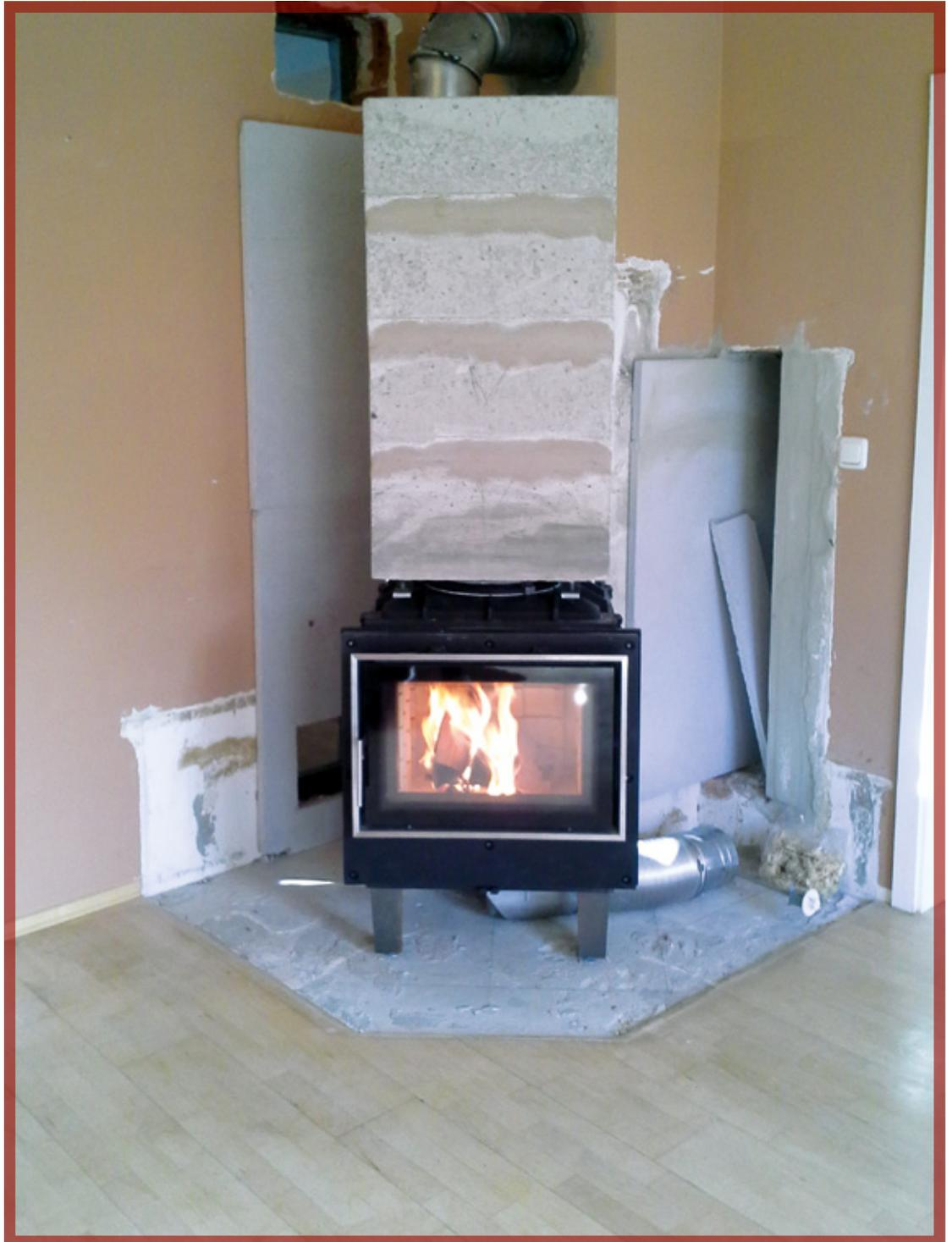
4. Zugaufsatzteil mit Probeheizung
