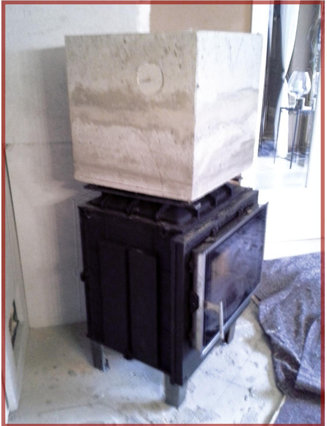
2. Zugaufsatzteil mit Putzdeckel
